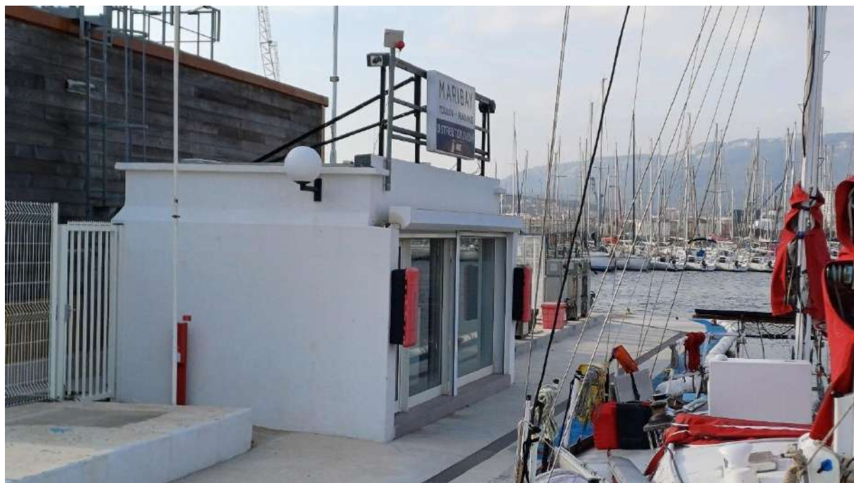
Travaux de rénovation : Ravalement de façade du bureau de la station d'avitaillement
