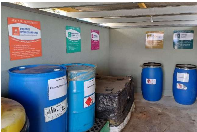
Remplacement de la couverture du Point propre
